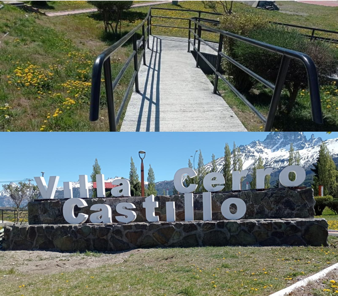
Fotografías de la obra
