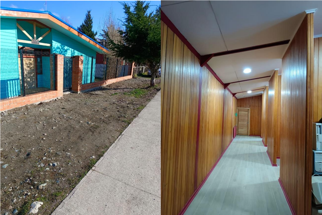
Fotografías de la obra
